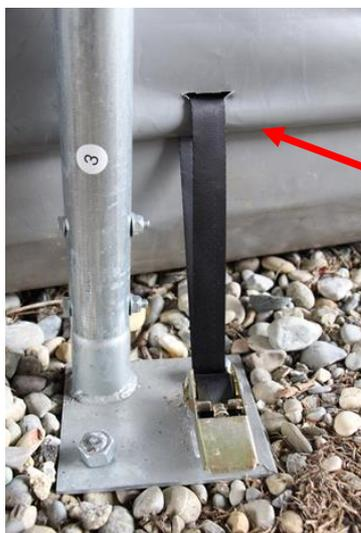
Schneiden Sie die Öffnungen für die Spanngurte oberhalb der Niederhaltestange.
