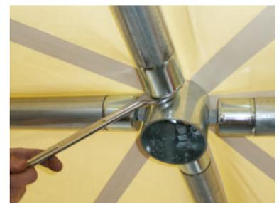
Die Dachblache gleichmässig am Mittelstück mit einem 24 mm Gabelschlüssel spannen
