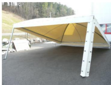
Die Struktur hochheben und die Fussstütze mit Fussbasis montieren. Die Fussstütze muss mit dem Eckwinkel und der Fussbasis verschraubt werden
