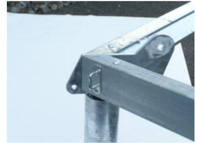
Befestigung der Seitentraverse mit Schrauben, ohne Gegengewinde
